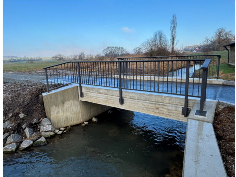
Ersatzneubau einer Brücke in Högl Dorf
