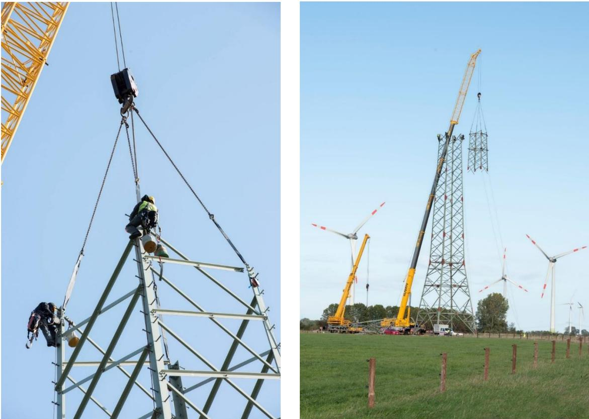
Abbildung 32: Mastmontage mittels Mobilkran
