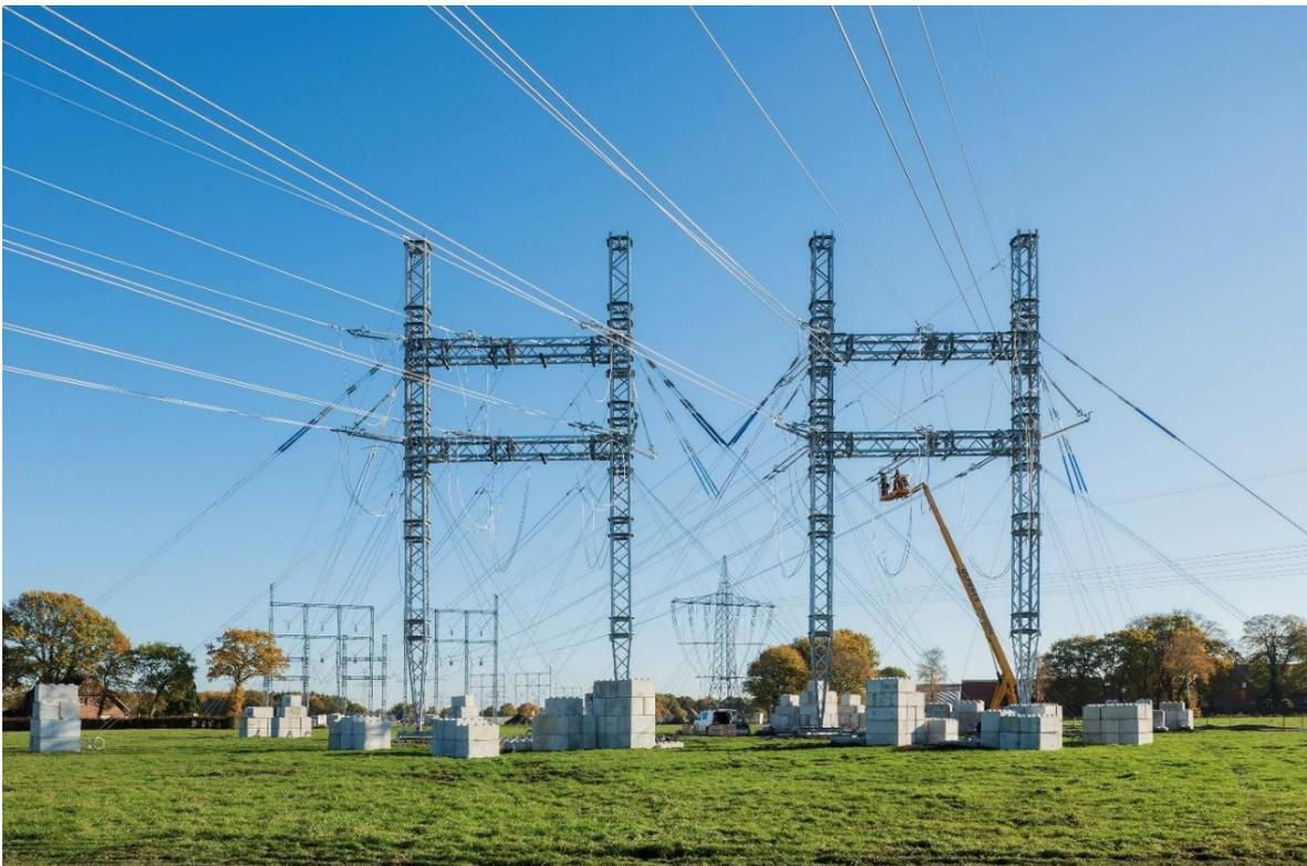
Abbildung 29: Freileitungsprovisorium für zwei 380-kV-Stromkreise
