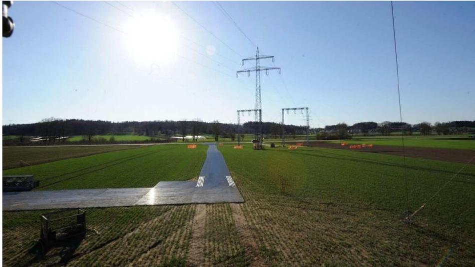
Abbildung 1: Provisorische Zuwegung als Plattenzufahrt bei einer Freileitungsbaustelle
